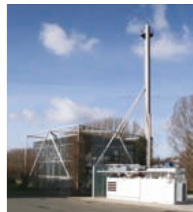
Pflanzenöl als Energieträger Das hauseigene Kraftwerk produziert bei 7.500 Stunden durchschnittlicher Laufzeit mit 3.000.000 Kilowattstunden etwa den jährlichen Strombedarf von Wilkhahn und die entstehende Abwärme wird gleichzeitig direkt als Heizungsenergie genutzt. Dadurch verfügt das Kraftwerk über einen Wirkungsgrad von 82%!
