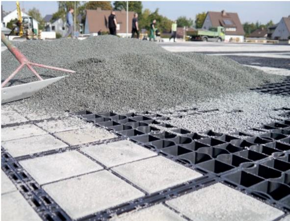
ECORASTER® können **ohne schweren Maschineneinsatz schnell und unkompliziert verlegt** werden. Die Bodengitter werden in vorgesteckten Lagen geliefert.
